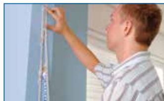
Ausmessen der Türöffnung (Breite und Höhe).
