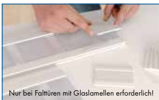
Abschlussblenden mit doppelseitigem Kleband unten in die gekürzten Glaslamellen einkleben.
